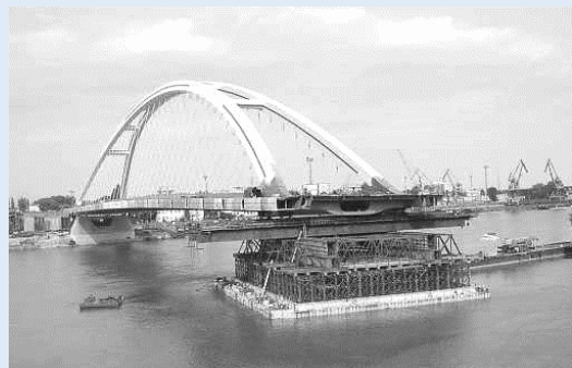
Apolló híd beúsztatás közben
