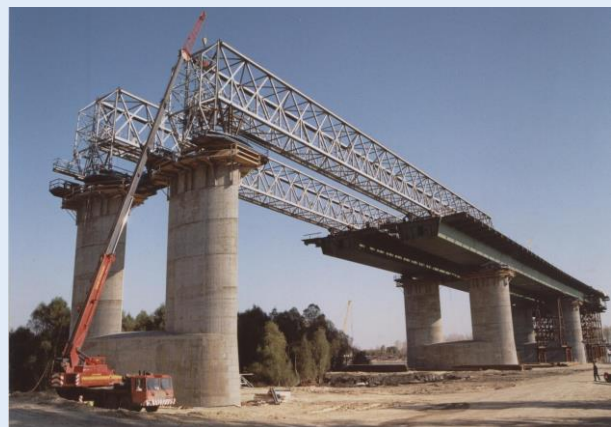
A dunaújvárosi ártéri híd építése
