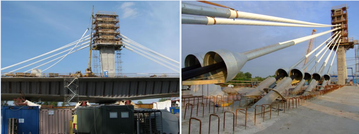
M43 Tisza-híd építés közben
