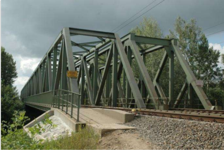
Vasúti terhet viselő szerkezetek 1 Gyoma Hármas - Körös hidak (3*66,00 m tmk.)
