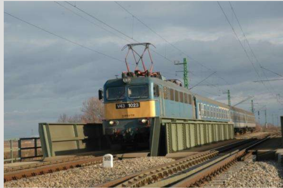
Vasúti terhet viselő szerkezetek 2. Mezőtúr Hortobágy - Berettyó főcsatorna hidak (31,00 m tmk.)
