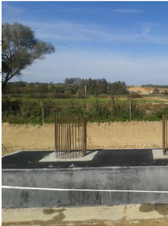
Alapozás: \Phi 1,0 m átmérőjű fúrt vasbeton cölöpök 8,0 – 10,0 m cölöphossz
