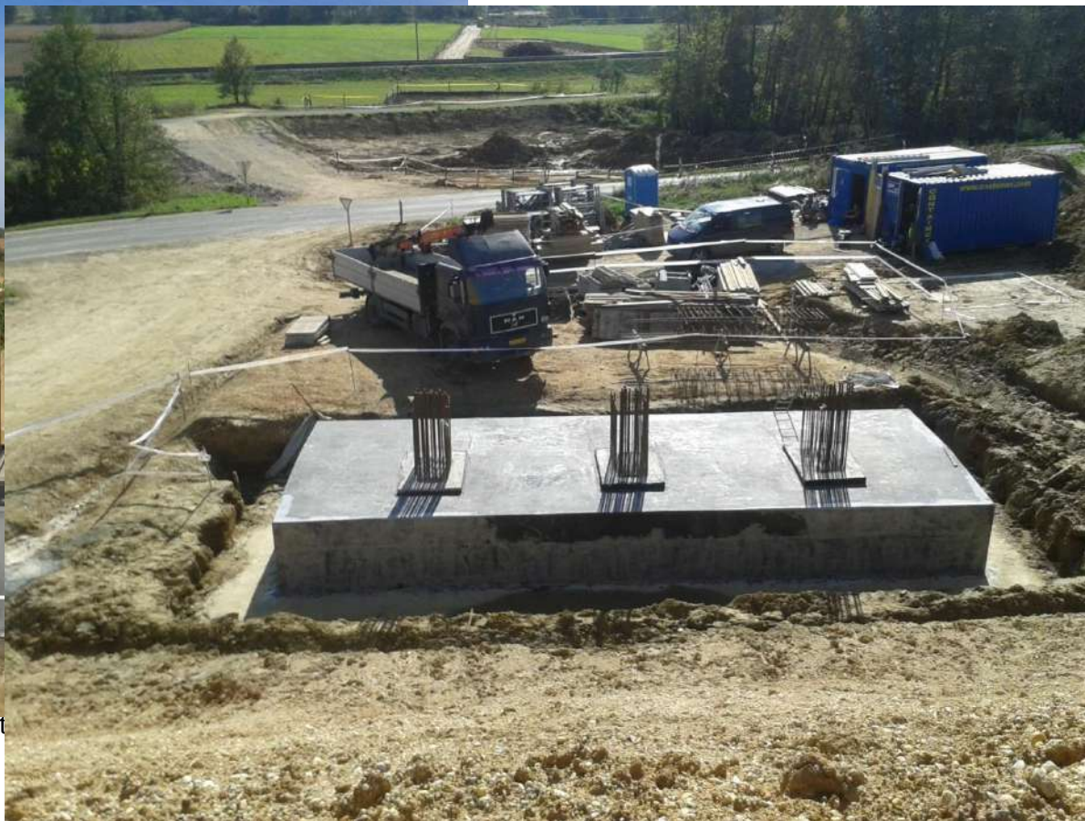
Alapozás: \Phi 1,0 m átmérőjű fúrt vasbeton cölöpök 8,0 – 10,0 m cölöphossz
