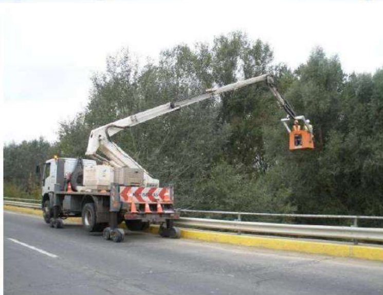
7. kép: Felszerkezet állapotfelmérése hídvizsgáló kocsiról (2010. szeptember 16., MSc Kft.)
