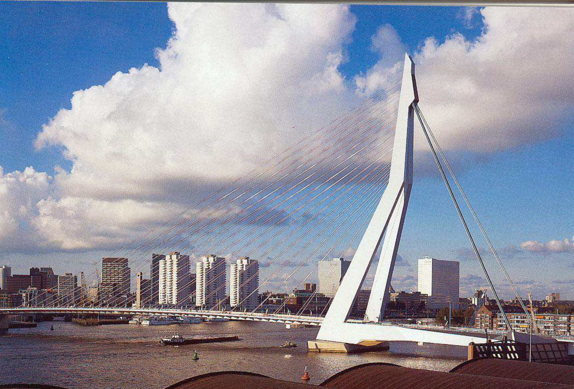
A rotterdami Erasmus híd; Van Berkel & Bos Építésziroda, Amszterdam, Építőmérnök Ingenieursbureau Gemeentewerken, Rotterdam.
