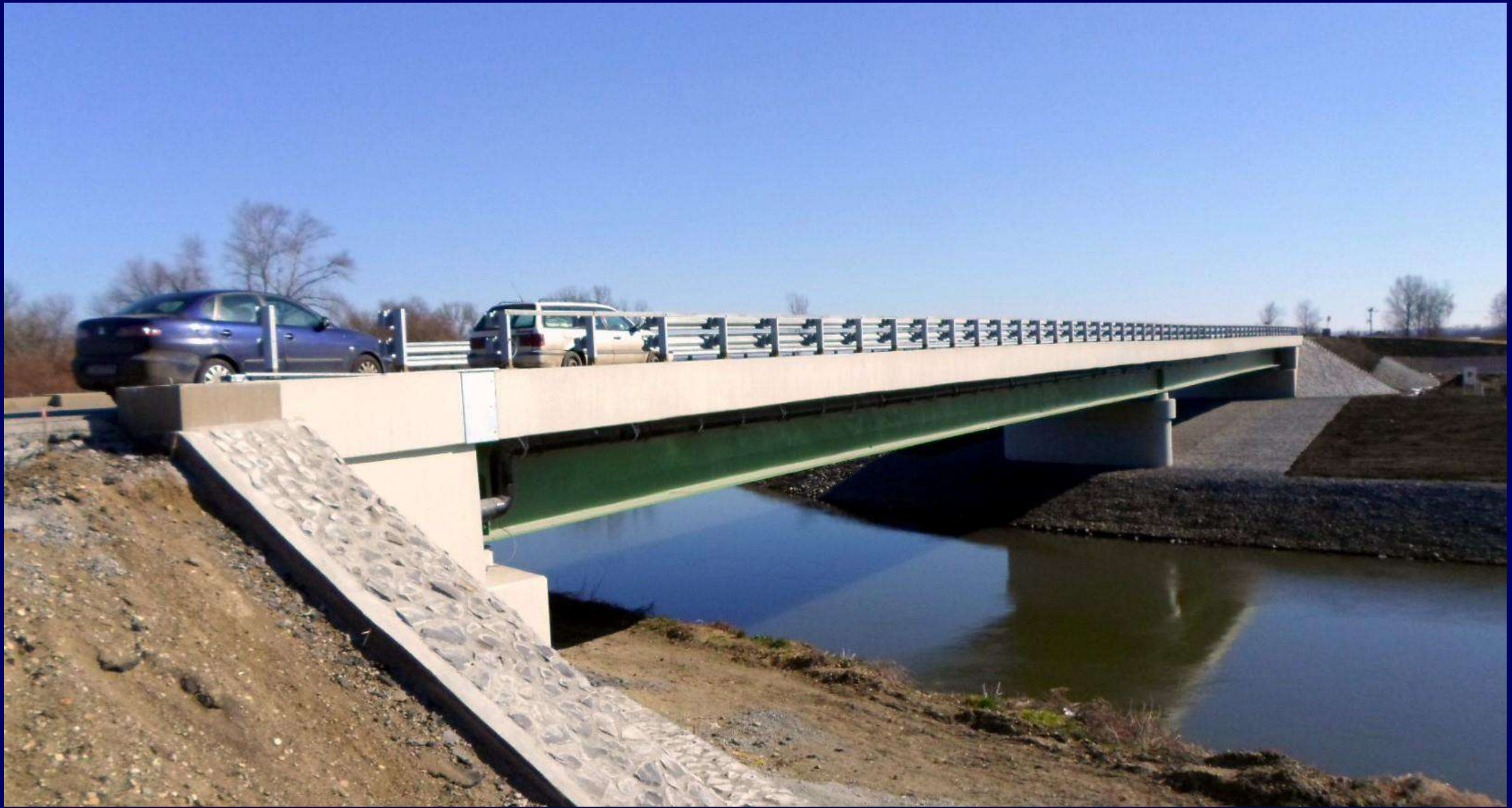
306 sz. úti Sajó-híd, 2014
