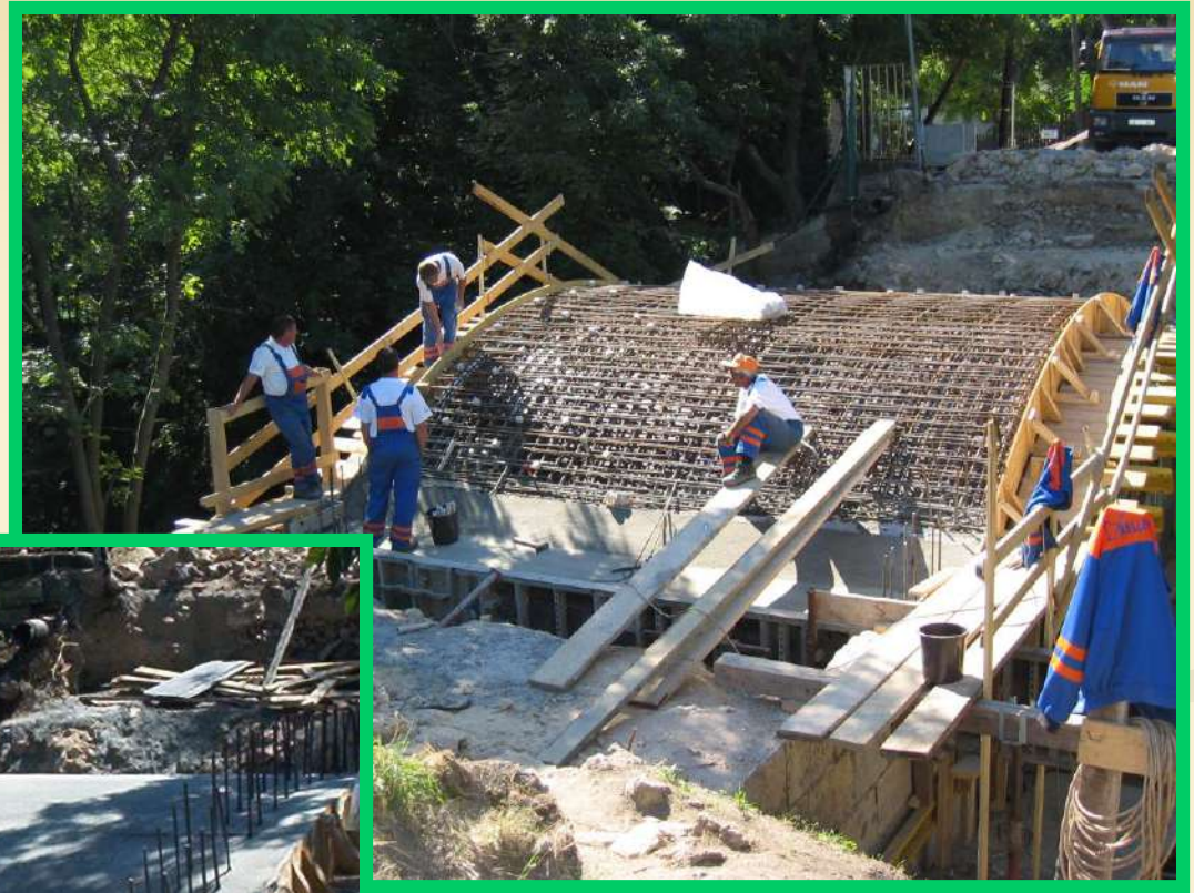
A dongahéj vasszerelése
