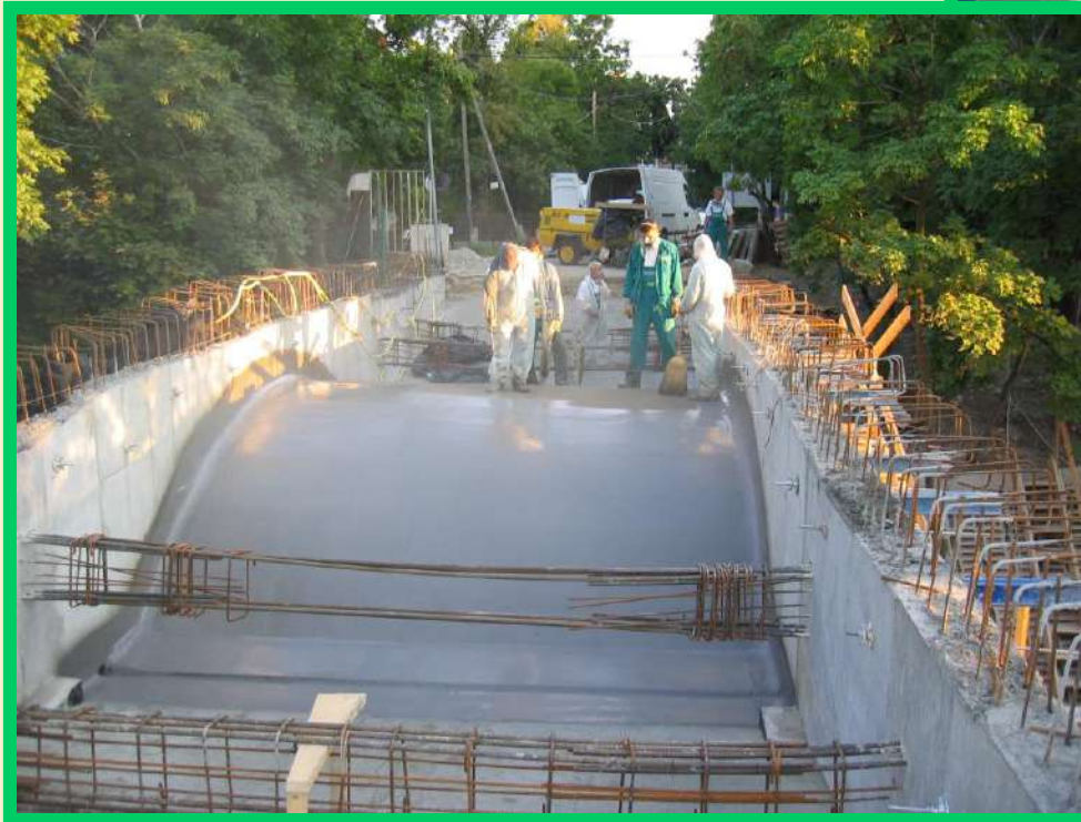
Szórt szigetelés készítése
