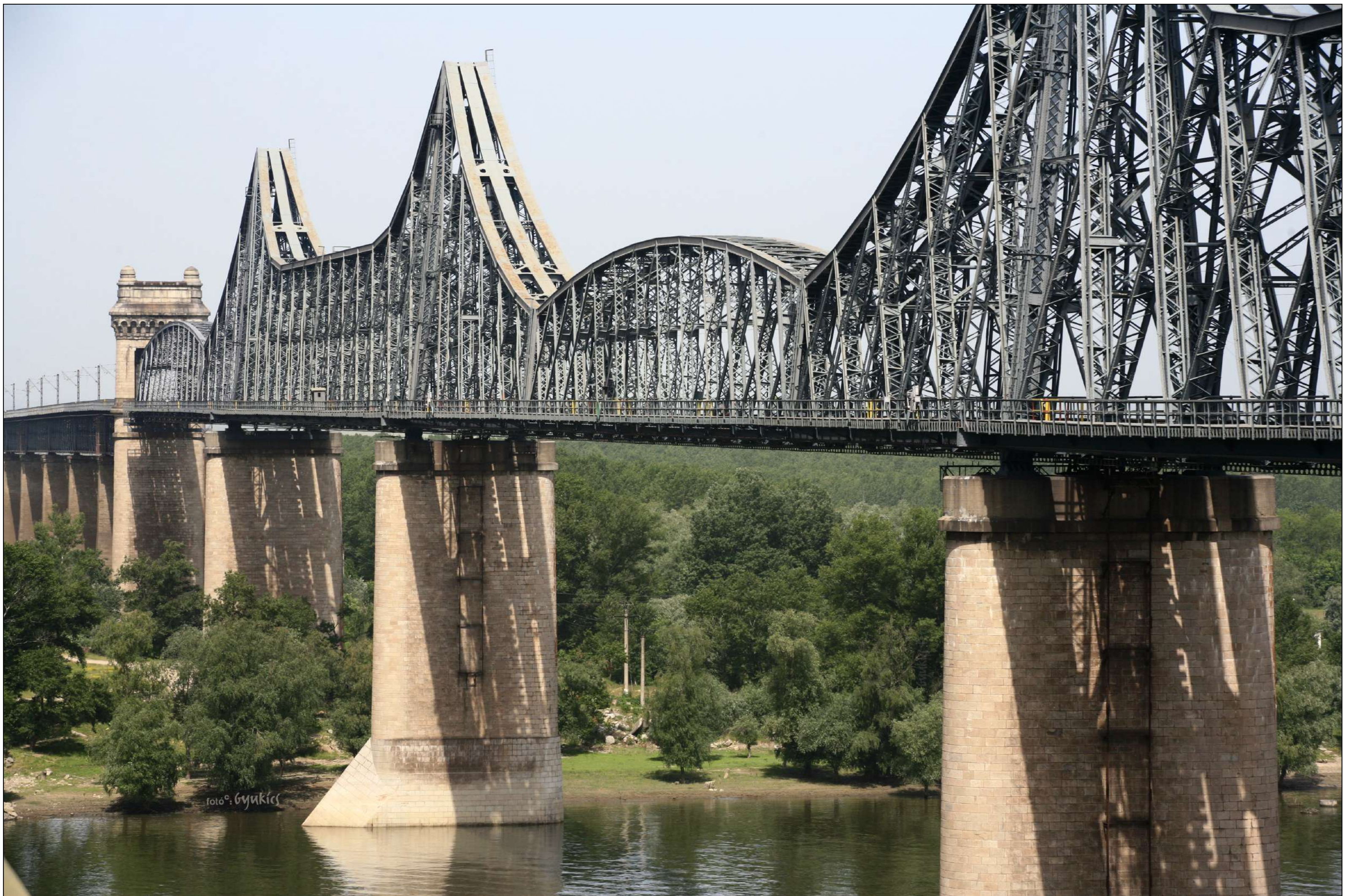
Tipikus Gerber tartós híd, I. Károly király, újabbán Anghel Saligny vasúti Duna-híd. Csernavoda (Románia) 1895.
