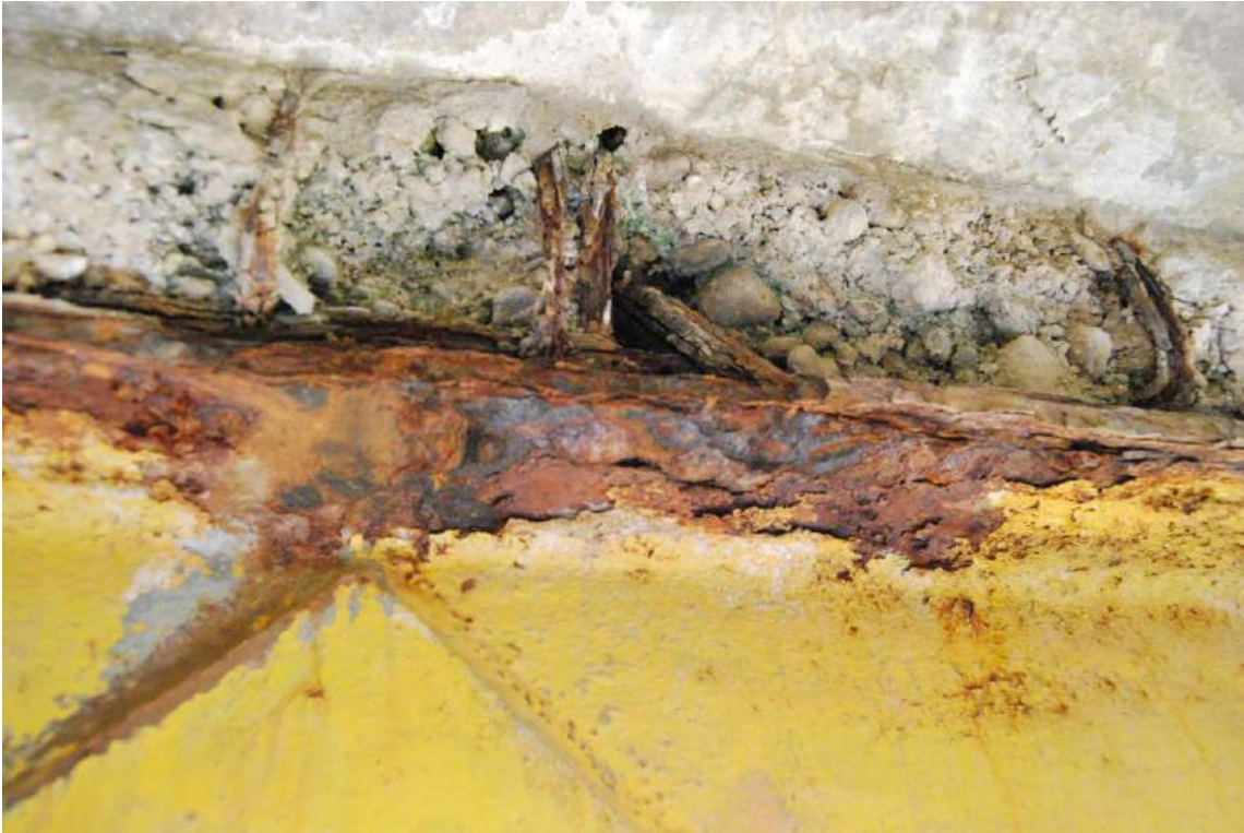
Tura: A szegélyborda fészkes részén az átázás intenzívebb, így az acélbetétekben 2x2 mm, a felső öv belső szélén 2,5 mm mély korróziós bemaródás. (1. hossztartó; 0,45xL, belső oldal)
