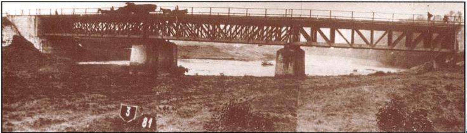
A miskolci Sajó-híd ideiglenes helyreállítása
