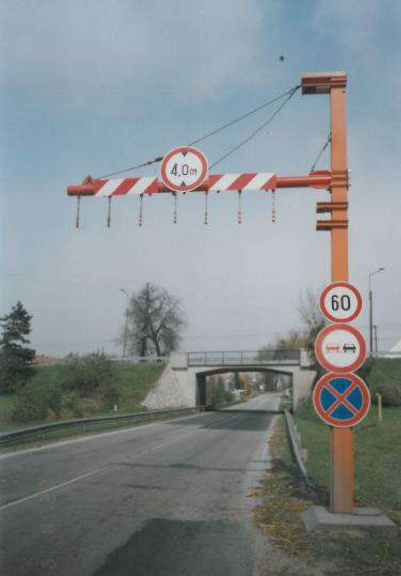
Mór, 81. sz. főút feletti híd
