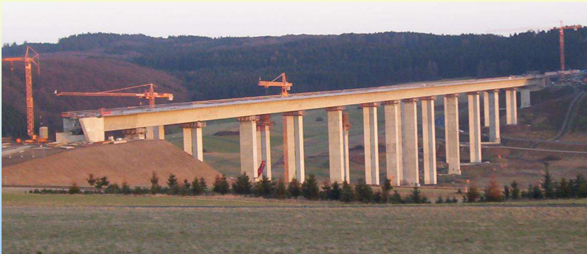
Lieser völgyhíd: építési állapot segédpillérekkel
