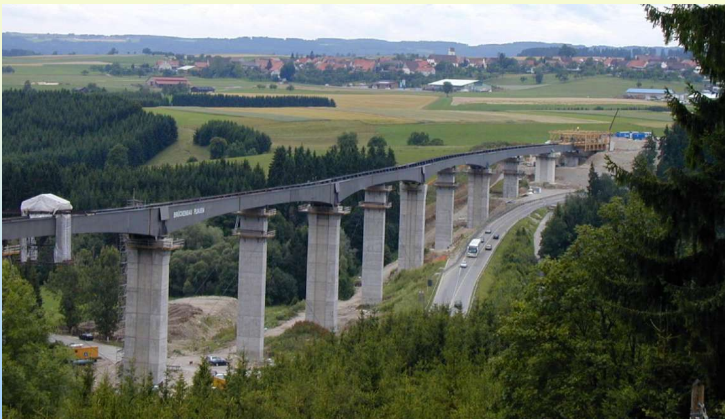
Gauchach völgyhíd: acél felépítmény építési állapotban
