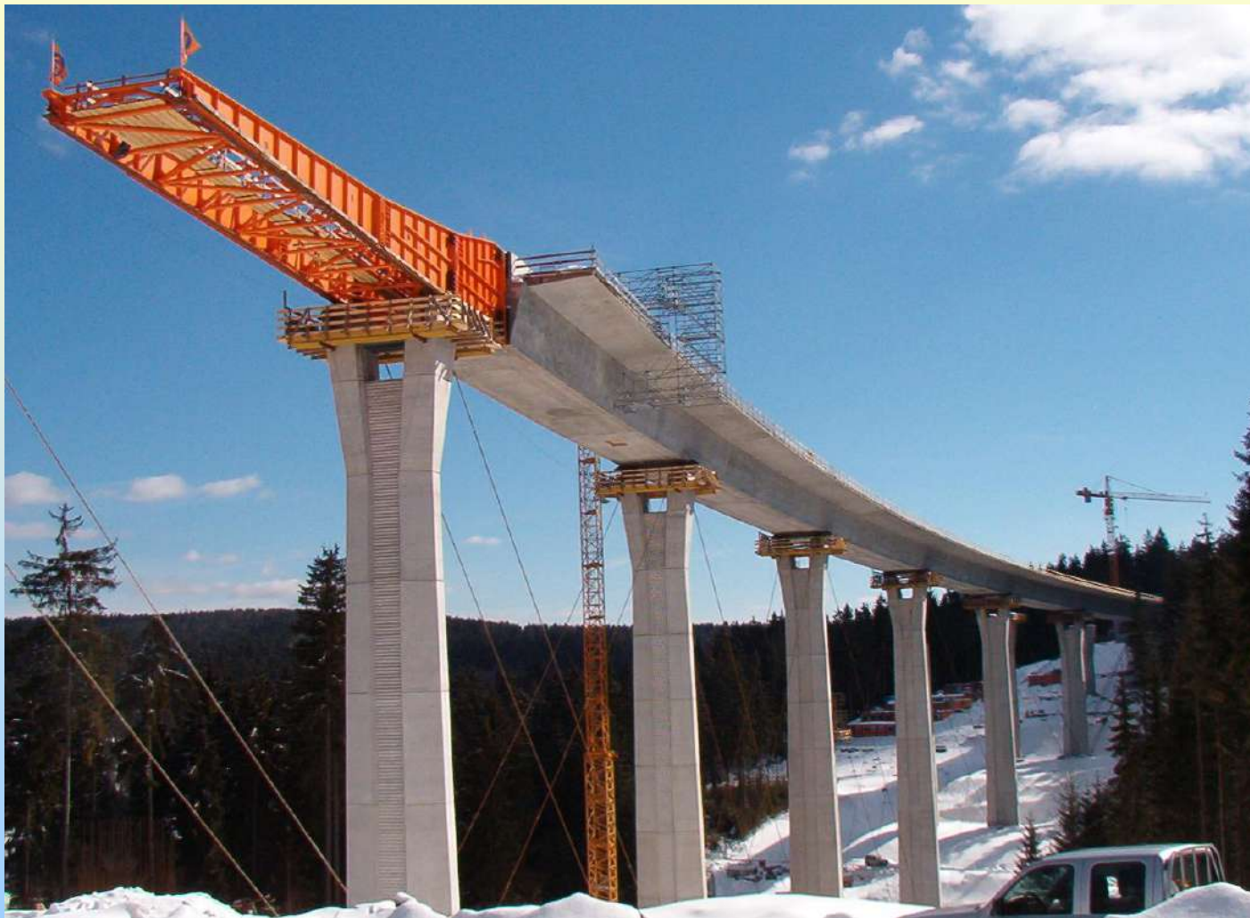
Wollersbach völgyhíd: Kábelekkel biztosított pillérek a szakaszos előretolásnál
