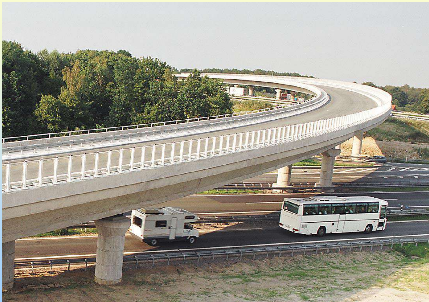
Flyover Münster: a kész híd
