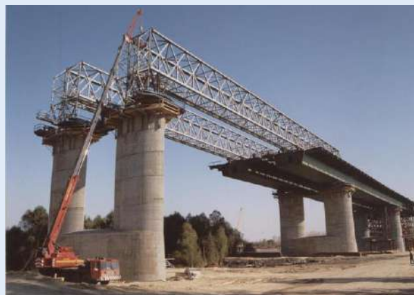
A dunaújvárosi ártéri híd építése
