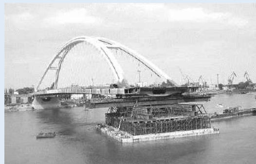
Apolló híd beúsztatás közben
