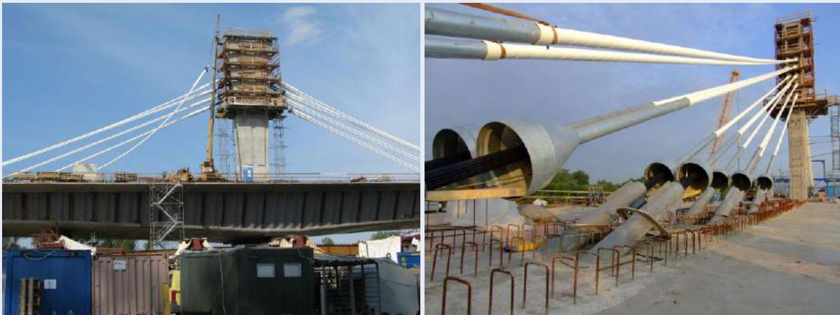
M43 Tisza-híd építés közben
