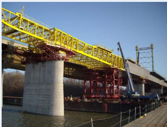
6. kép: A vásárosnaményi új Tisza-híd építése
