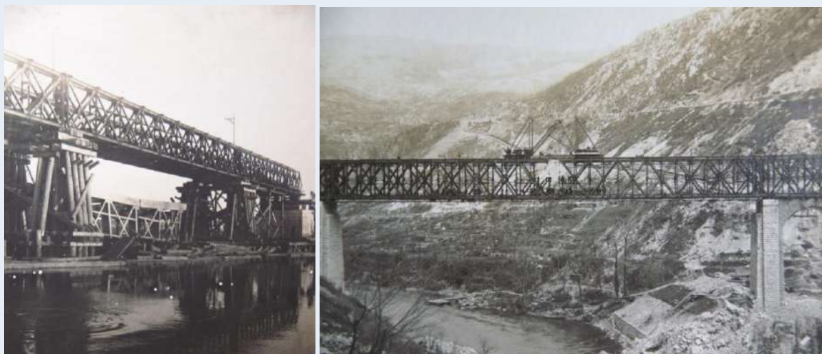
8. kép: Vasúti provizóriumok: Kohn és Roth-Waagner híd
