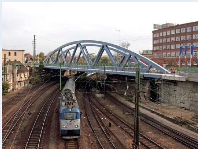
6. kép: Acél ívhíd a „százlábú” híd helyén
