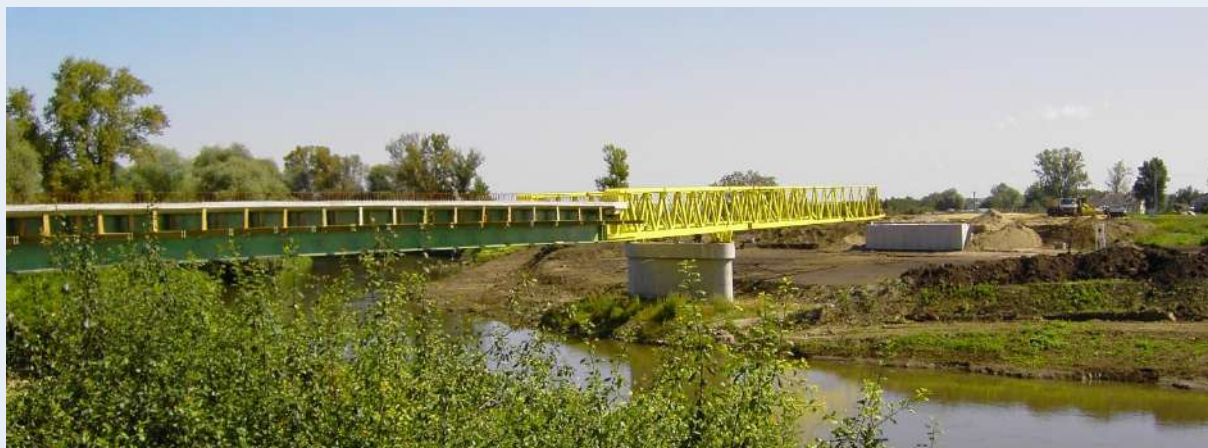
9. kép: A miskolci Sajó-híd betolás közben
