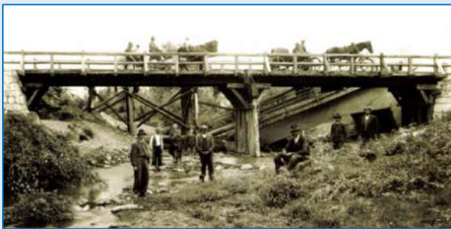
A pásztói Zagyva-híd roncsa mellé épített ideiglenes fahíd
