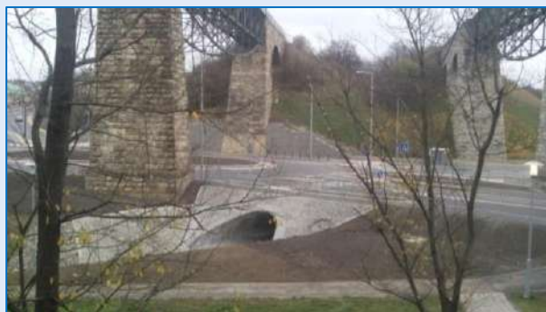
19. ábra: A biatorbágyi viadukt tövében épült műtárgy
