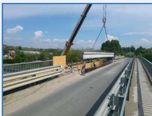
15. ábra: Új gerenda beépítése az M3 feletti Fót, Sikátorpusztai úti hídon
