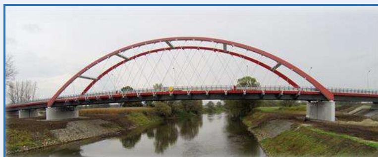
4. ábra: Odera-híd bontása és újjáépítése
