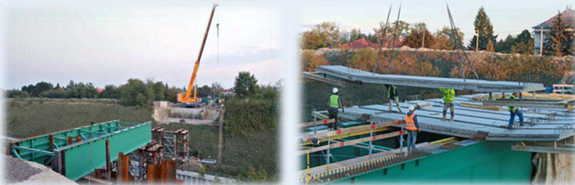
4. ábra: Érdi vasút feletti hidak építés közben
