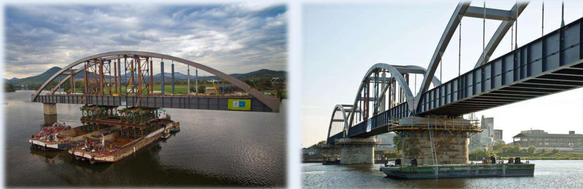
3. ábra: Lovosice-i híd építés közben és az átadás után
