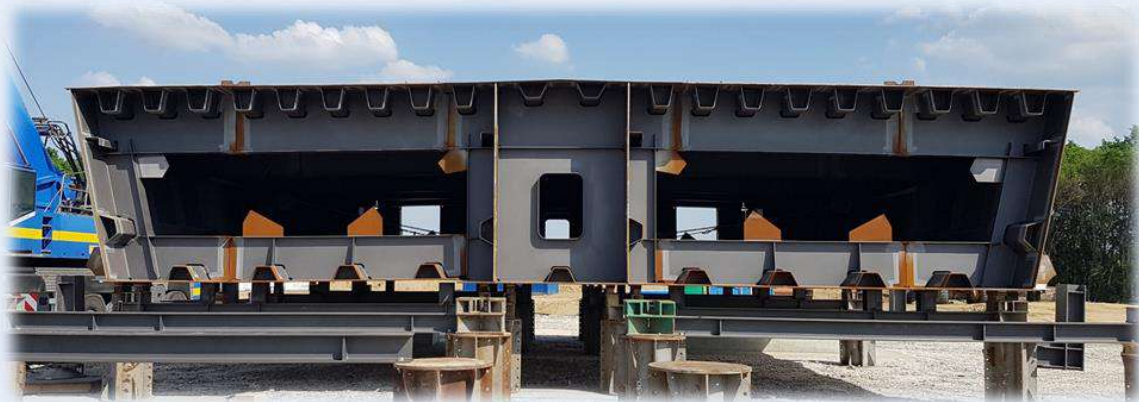
10. ábra: A Körös-híd mederhídjának keresztmetszete
