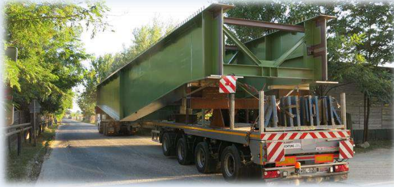
12. ábra: A H1jelű híd acélszerkezetének szállítása
