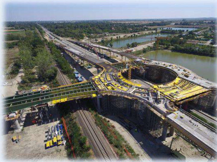
13. ábra: A körhíd építés közben (2017. augusztusi felvétel)
