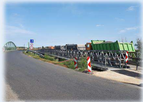
5. ábra: Sióagárdi provizórium a próbatelhelése közben, háttérben a Sió-híd
