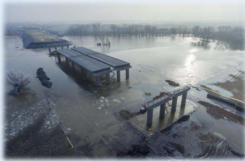
9. ábra: A Körös-híd ártéri nyílásai építés közben
