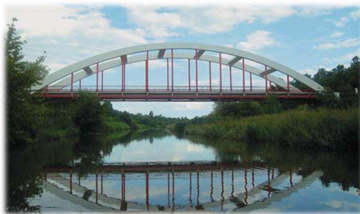
Tiszaörsi „Bocskai” Keleti-főcsatorna-híd
