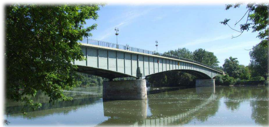
Tokaji Tisza-híd építés közben és napjainkban
