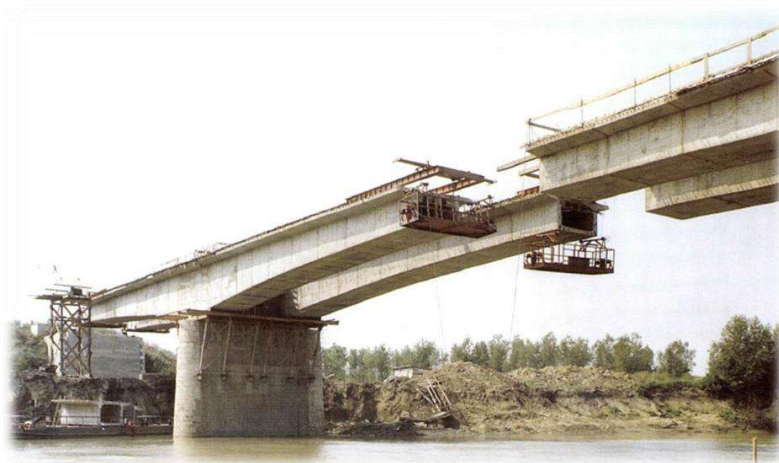
A kunszentmártoni Hármas-Körös-híd építés közben
