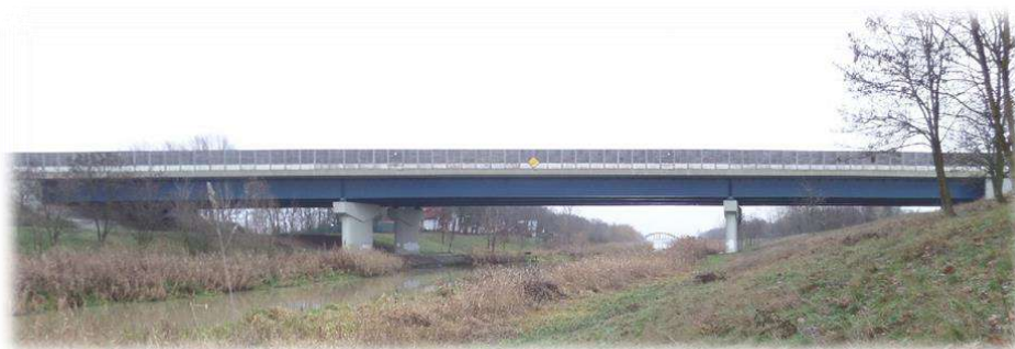
Keleti-főcsatorna-híd az M3 autópályán
