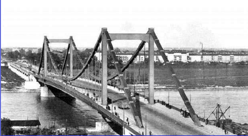
Reichsbrücke vor Einsturz
