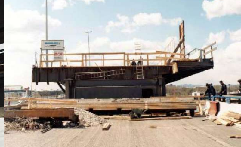
Hebung der Praterbrücke um 4,5m am linken Stromufer
