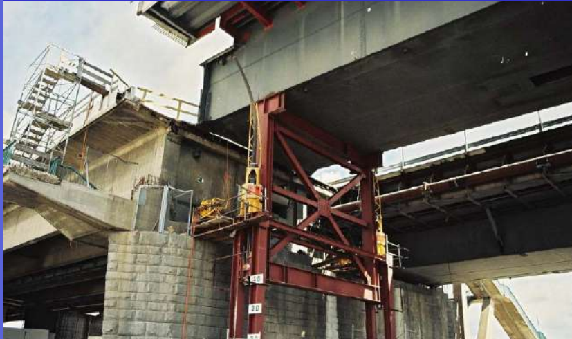
Hebung der Praterbrücke um 4,5m am linken Stromufer
