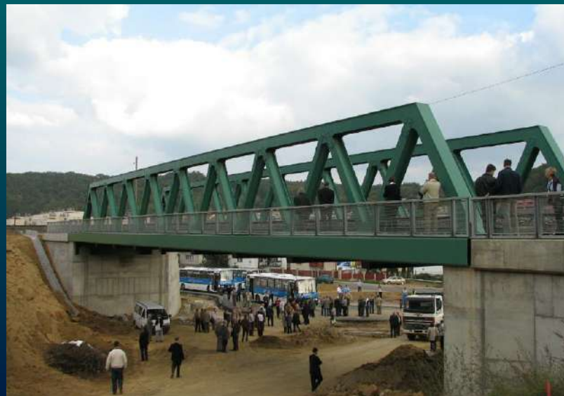
2007 A salgótarjáni rácsos vasúti híd
