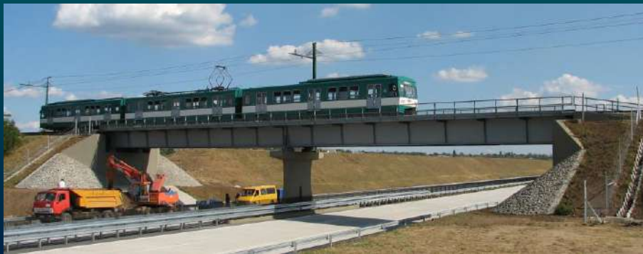
M0 625 HÉV híd
