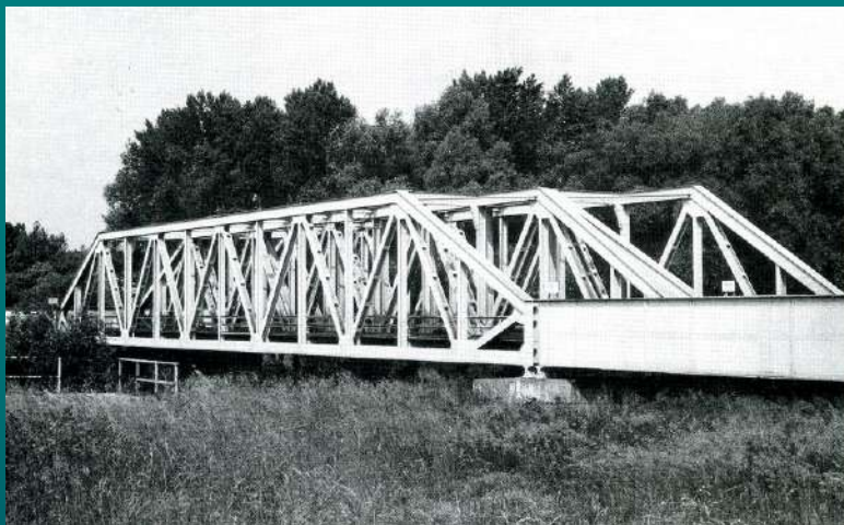
1965-ben a győri Rába-híd még szegecselt szerkezettel épült
