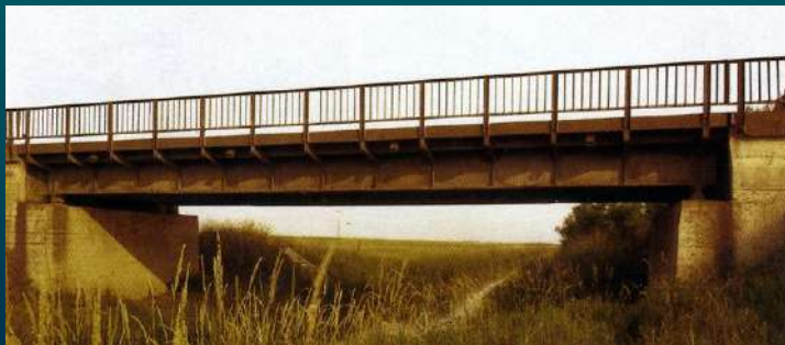
1960 A Laskó patak hídja kísérleti jelleggel ortotrop pályával épült
