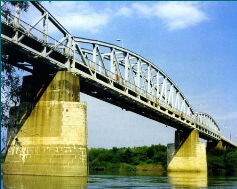
1957 Kiskörei közúti – vasúti Tisza-híd
