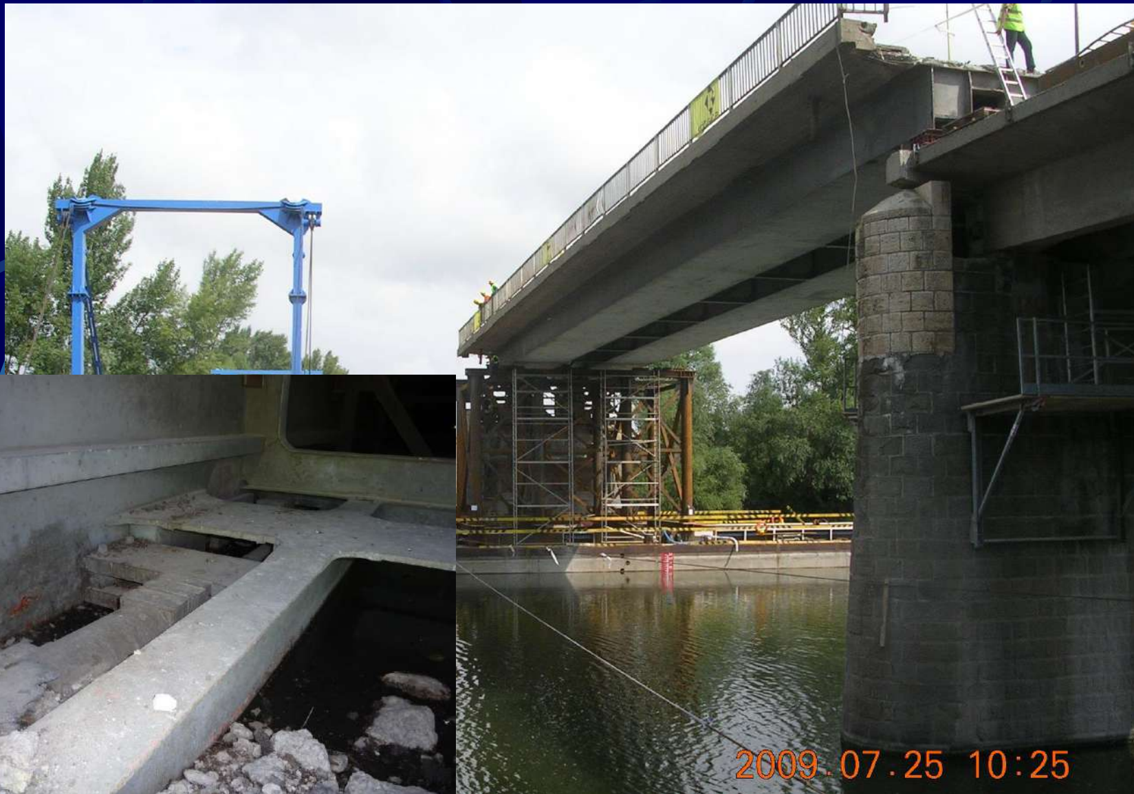
49,0 m Endrődi Hármaskörös híd 1968
