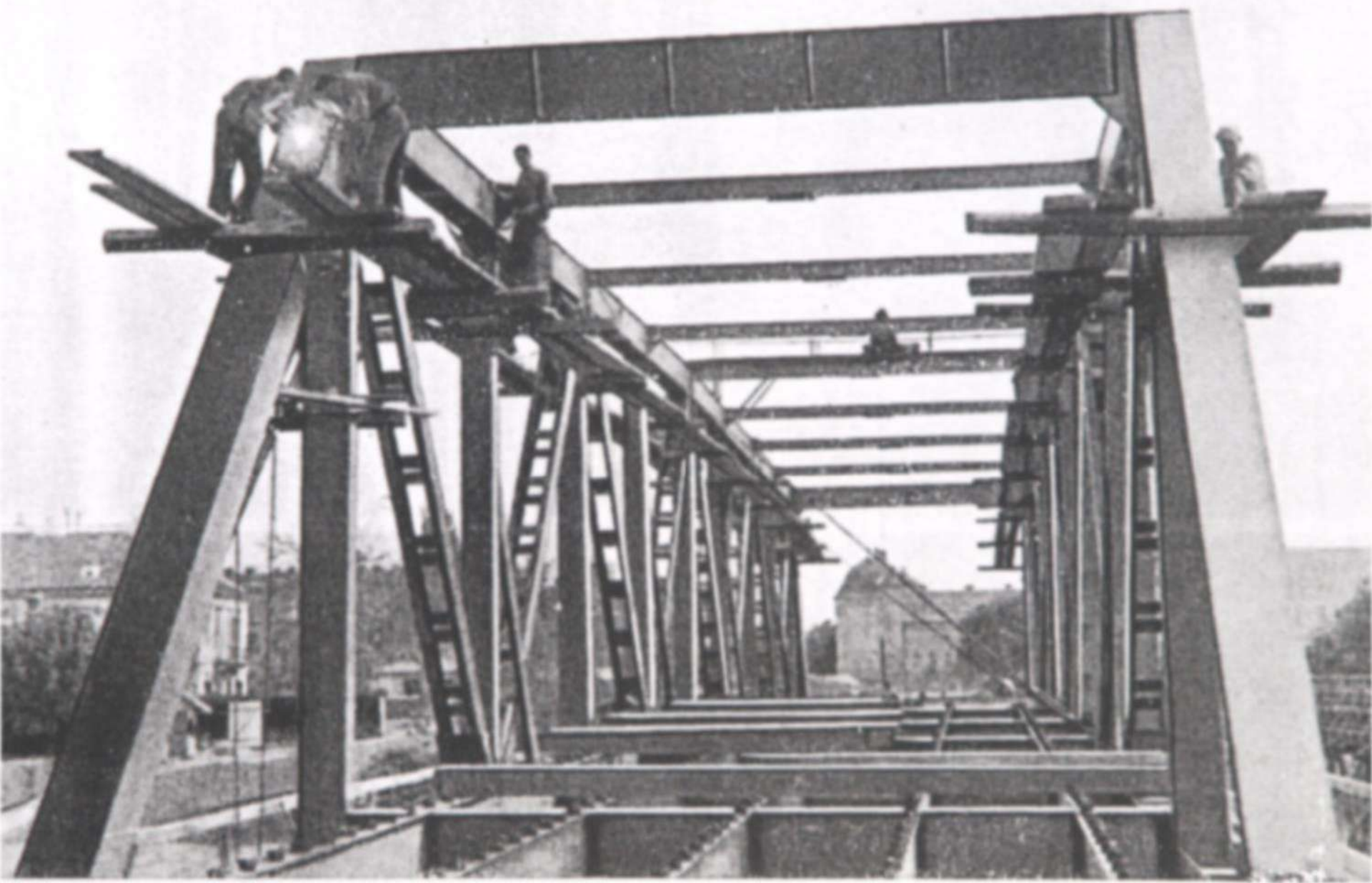
GYŐRI KÖZÚTI RÁBAHÍD SZERELÉSE, ELŐTÉR BEN 2 HEGESZTŐVEL. (Magyar Waggon- és Gépgyár r. t. Győr-Budapest.)
