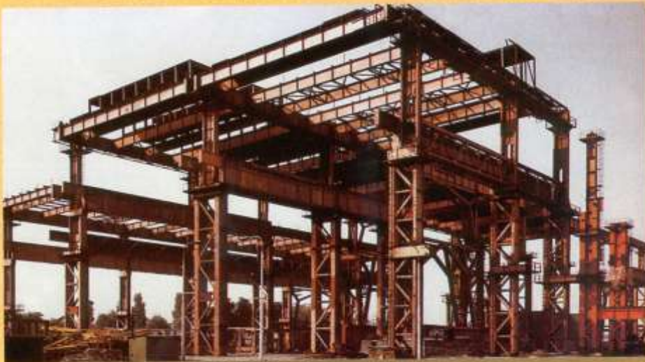
A Dunaújvárosi Konvertes Acélmű csarnokainak szerelése 1979
