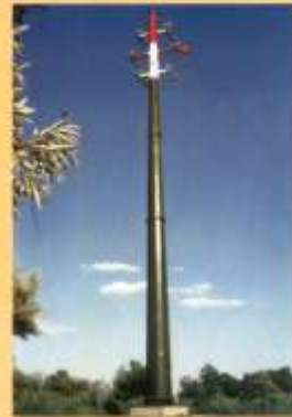
Korszerű távvezeték-tartó oszlop
