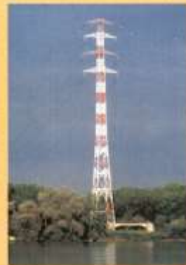
A 90 m magas, hagyományos nagyfeszültségű távvezeték-tartó oszlop
